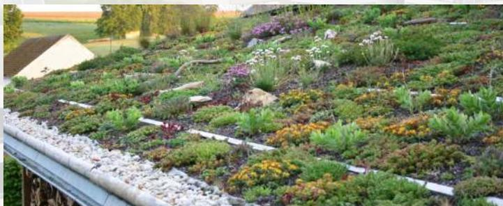
flächenhaft zu begrünen sind. Dachflächen mehrerer Gebäude oder Gebäudeteile gelten als eine Dachfläche, wenn diese als ein Vorhaben genehmigt oder verwirklicht werden. Die Dachbegrünungen sind als extensive Gründächer herzustellen (Substratstärke der durchwurzelbaren Schicht: mindestens 5 cm).“<sup>2</sup>
