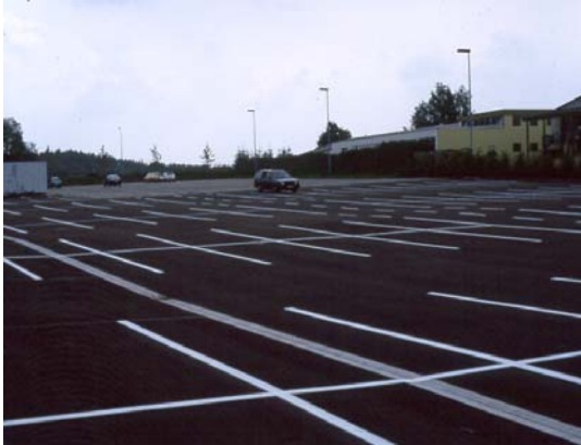
Bild 3-2: Wasserundurchlässige Befestigung bei Großparkplätzen
