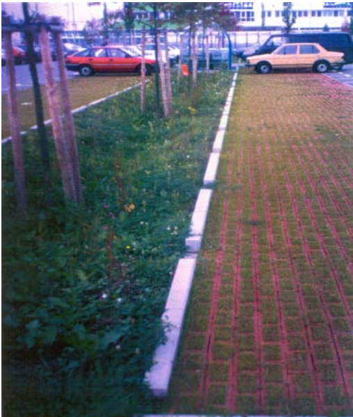
Bild 3-4: Durchlässige Befestigungen kombiniert mit bewachsenen Versickerungsmulden
