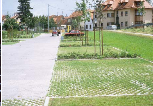
Bild 3-3: Durchlässige Befestigungen mit Rasengittersteinen
