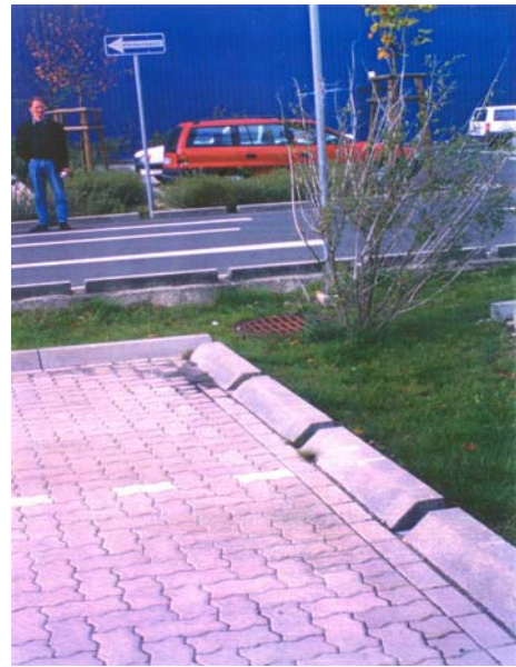
Bild 3-5: Definierte Versickerung über Rasenmulden bei wasserundurchlässiger Befestigung
