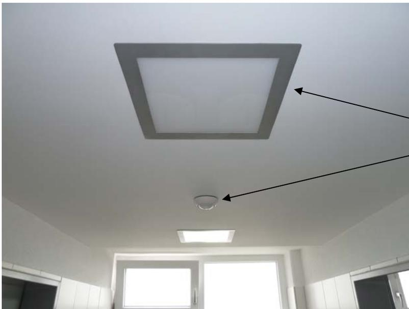
Saniertes WC mit eingebauten LED Panels 19W/980 Lumen und Präsenzmelder.
