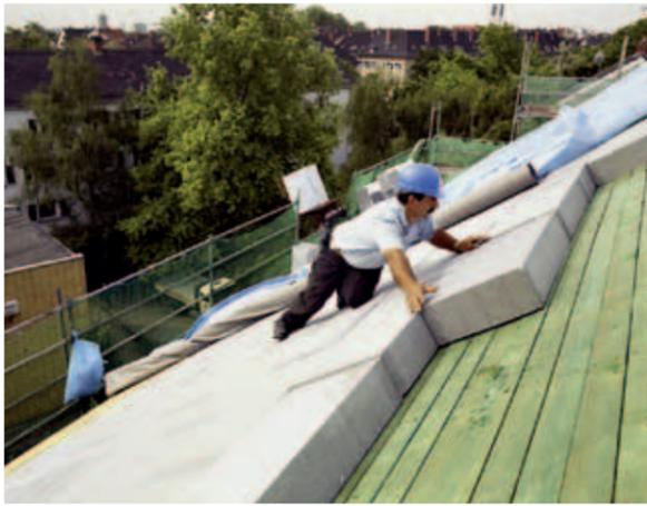
Dachdämmung verhindert Wärmeverluste
