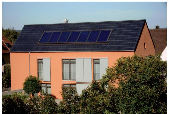
Niedrigenergiehaus mit Pelletheizung und thermischer Solaranlage
